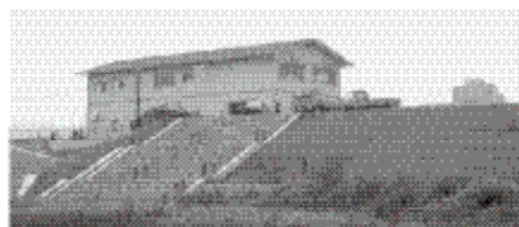
7月7日に完工した芥川水防センター
